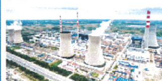
火力发电 俄罗斯特罗伊茨克国营电站2X660MW发电机组建设项目
