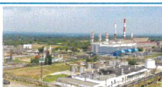
生物质电站 古巴西罗雷东多1X60MW生物质电站项目
